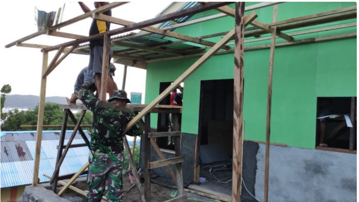
Pekerjaan RTLH Keluarga Galvin Karaki Oleh Satgas TMMD Ke-116 Kodim 1310 di Kelurahan Tandurusa
