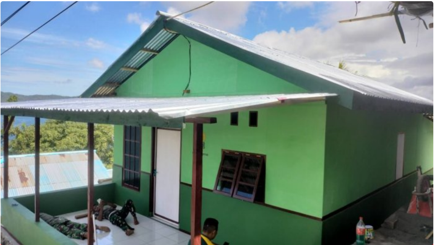
Renovasi RTLH TMMD Ke-116 Kodim 1310 Bitung
